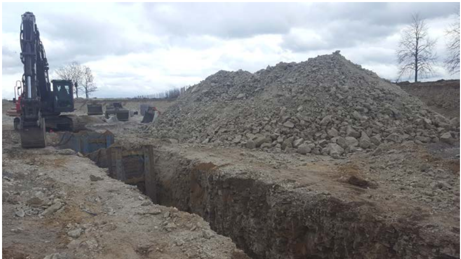
Abb. 2: Graben für Kanalisation und Rohrleitungsbau, Foto Säbele
