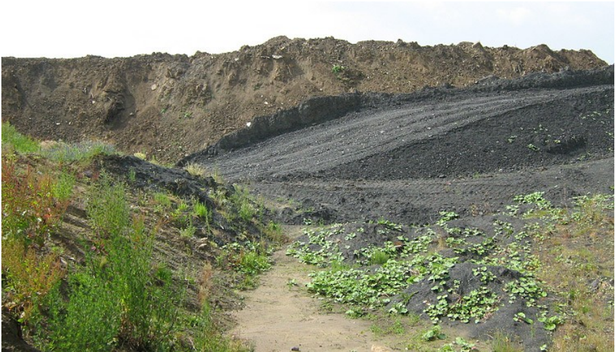
Abb. 1: Blick in den Nordteil der Tongrube (Verfüllstand: Mitte 2008)
